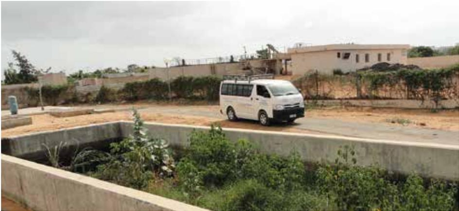
*Figure 6.5 : Exemple d'exploitation-maintenance inadaptée d'un bassin de décantation et d'épaississement en Afrique de l'Ouest. La couche d'écume qui n'a pas été extraite depuis longtemps sert de support au développement de végétaux. Les volumes de boues et d'écume accumulés dans l'ouvrage ne permettent plus d'atteindre la performance escomptée et nécessitent des moyens plus importants pour le nettoyage (photo : Sandec).*
