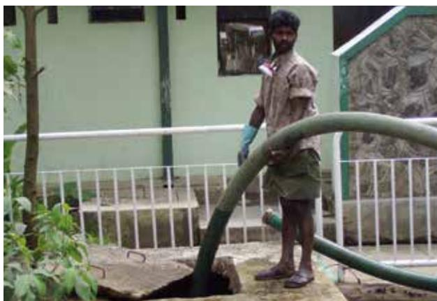
*Figure 4.1 : Vidange d'une fosse septique à l'aide d'un équipement d'aspiration sous vide. La sécurité des opérations serait meilleure avec des équipements de protection mieux adaptés (photo : David M. Robbins).*
