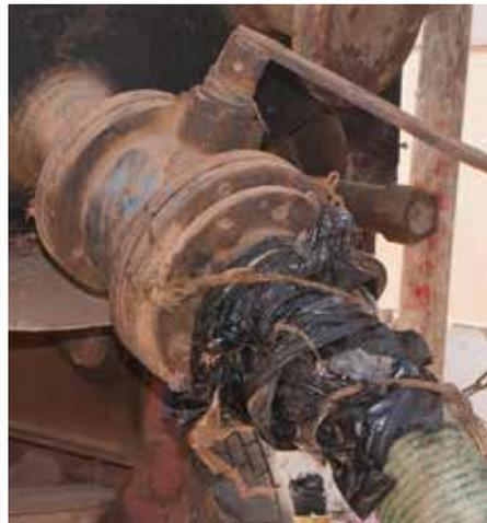
Figure 4.13 (droite) : Exemple d'un système mal entretenu avec des tuyaux assemblés à l'aide de ficelle et de sachets plastiques.
