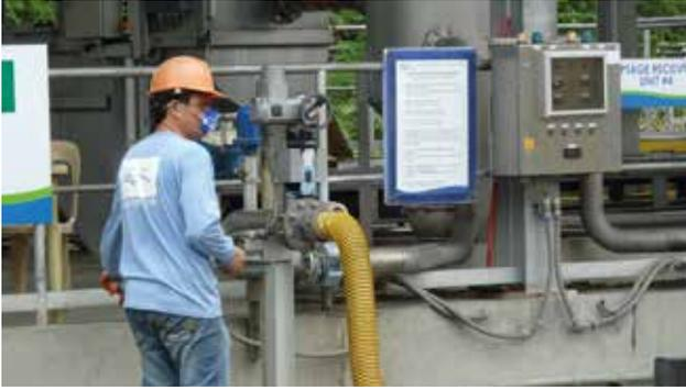
Figure 4.16 : Unité de dépotage mécanisée au niveau de la station d'épuration South Septage de la société Manila Water, à Manille, aux Philippines (photo : WSUP, Sam Parker).
