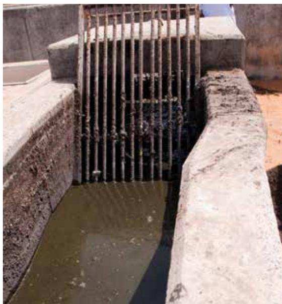
Figure 3.6 : Dégrilleur de la station de traitement des boues de vidange de Niayes, Dakar, Sénégal (photo : Linda Strande).
