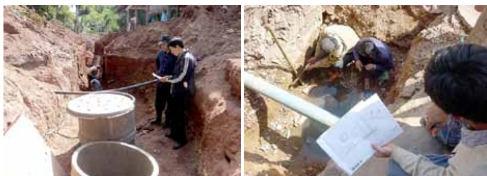
Construction d'un réseau d'égouts au Laos.
