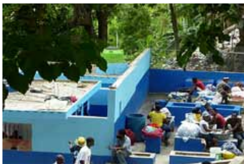
Lavoir du bloc sanitaire du quartier Tête de l'Eau (Haïti).
