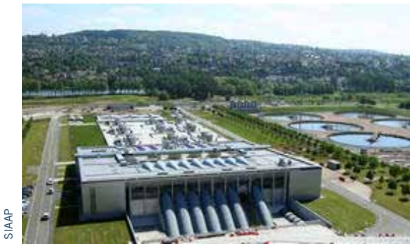
Usine de traitement Seine Aval (France).
