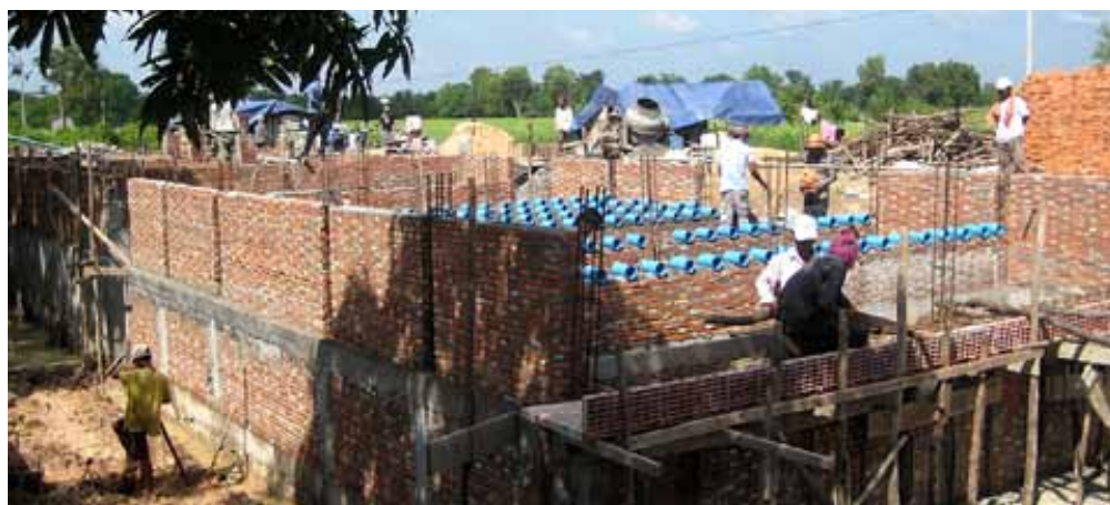
Construction d'une station de traitement des eaux usées au Cambodge.
