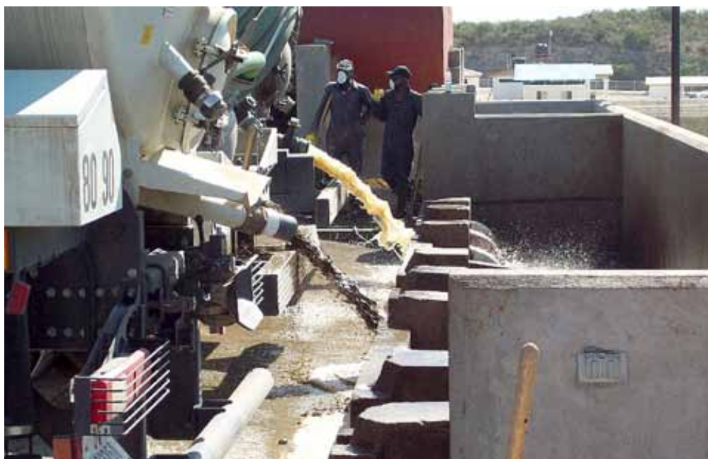
Dépotage des boues par des camions de vidange dans la station de traitement de Port-au-Prince (Haïti).
