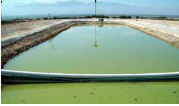
Bassin de lagunage en Haïti.
