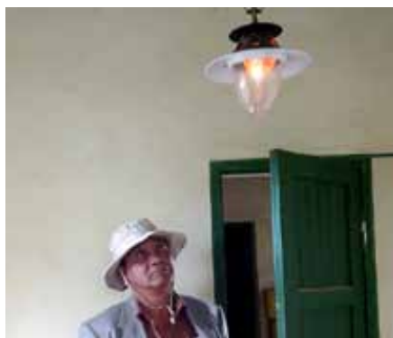
Lampe fonctionnant au biogaz, produit par une station de traitement de boues de vidange (Madagascar).
