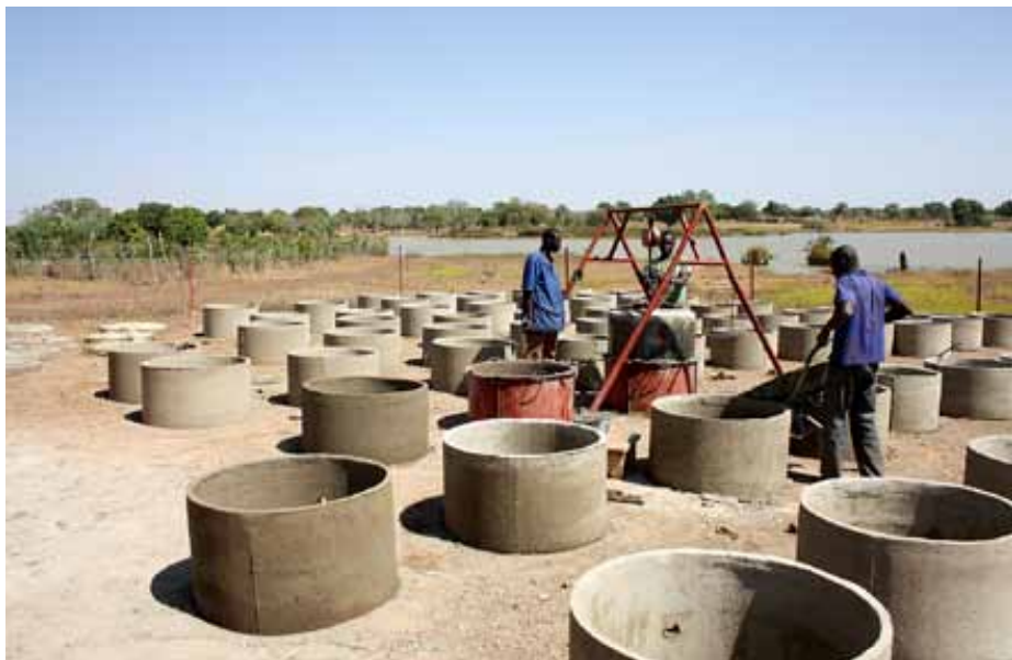
Site de production en série de buses pour les fosses des latrines à Fara (Burkina Faso).
