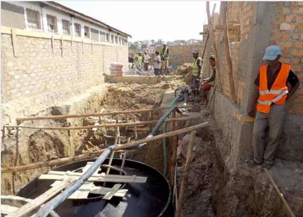
Chantier de construction d'une station de traitement à Antananarivo (Madagascar).
