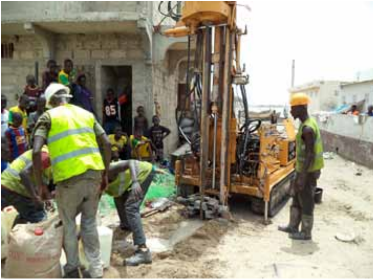
Étude géotechnique préalable à la construction d'un réseau d'égouts au Sénégal.
